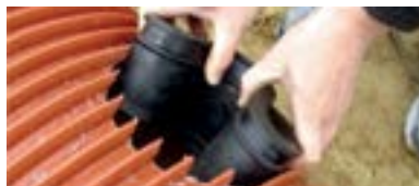
QS-Dichtung im Bohrloch platzieren
