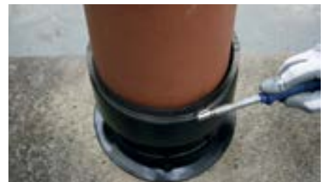
seitliches Rohr einsetzen und Spannband mit 6 Nm festziehen
