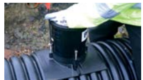
Schrauben gleichmäßig festziehen
