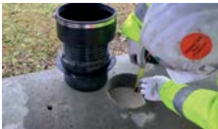
Kernbohrung anfertigen und Bohrung entgraten
