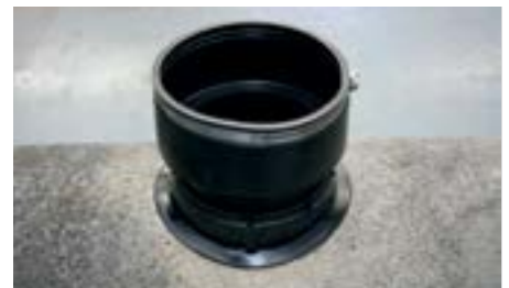
Element bündig aufsetzen, Radius beachten
