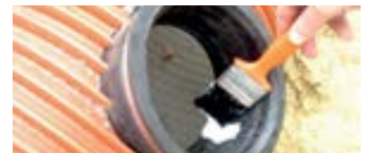
Dichtung innen mit Gleitmittel bestreichen (nicht unter dem Spannband)
