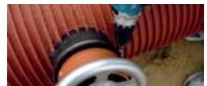
vor Entfernen des Werkzeuges das Spannband mit 8 Nm anziehen
