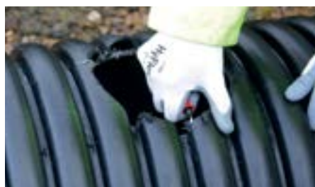
Bohrung entgraten
