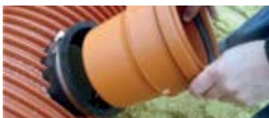
Rohr in die QS-Dichtung einführen
