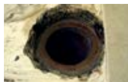
bündig abgeschnittenes Rohr
