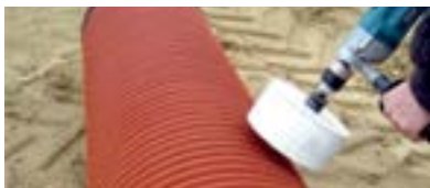
Bohrung in der angegebenen Größe herstellen und Bohrloch entgraten
