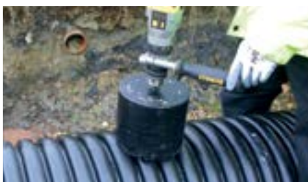
Kernbohrung anfertigen mit 177 mm (+ 2 mm / -0,5 mm) Durchmesser
