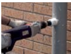
Kernbohrung anfertigen
