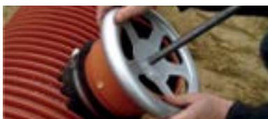
Dichtung mithilfe des Montagewerkzeuges richtig positionieren
