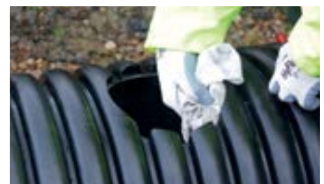
Innenfläche des Rohres reinigen
