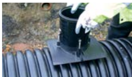
PA-Sattel so in die Bohrung einsetzen, dass der Sattelflansch fest auf dem Rohr sitzt
