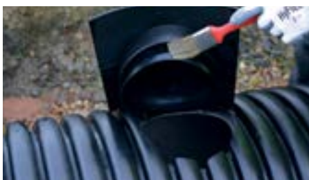
ausreichend Gleitmittel auf die Außenseite der Innenhülse und der Dichtung auftragen
