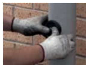
Rohrverschluss einsetzen
