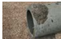
teils oder komplett einbetoniertes Rohr
