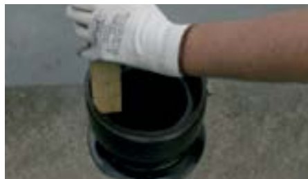
Spannhülse mit der Einschlaghilfe bündig einschlagen
