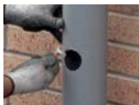
Bohrloch entgraten
